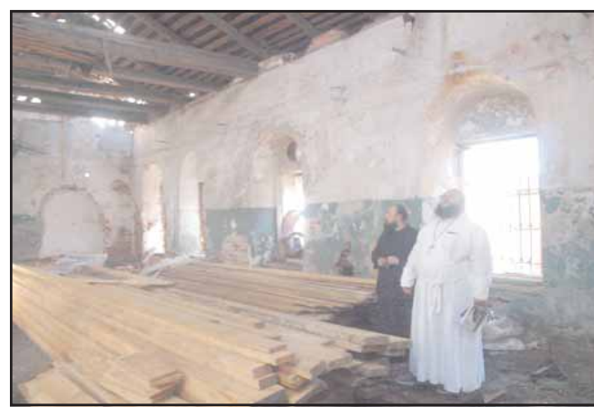
Осмотр храма в Станках
