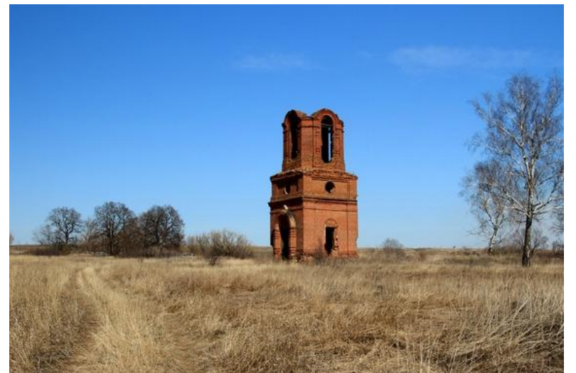
Колокольня Введенского храма в селе Чулково
